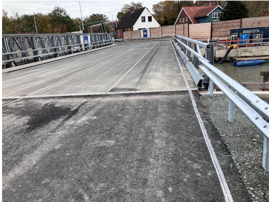
A 281 BA4 – Einschwimmkanal / Herstellung Provisorium Hasenbürener Landstraße - Nov. 2025
