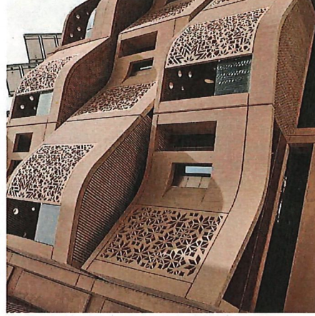
Sichtbetonoberflächen durch Schalungsmatrizen
