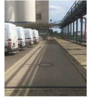
vorhandene Waage zwischen Silo und Gebäude 25
