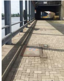
vorhandene Absturzsicherung und Rohrstruktur
