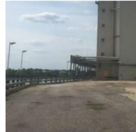
vorhandene Absturzsicherung, Silo Gebäude
