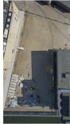
vorhandene Pflasterung zwischen Gebäude 25 und Silo, Schienen und Markierung
