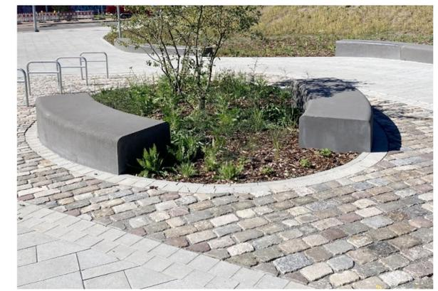
Beispielbild - Großsteinpflaster gesägt 16/16/14 cm, Reihenverband, Sitzmauer aus Betonfertigteilen
