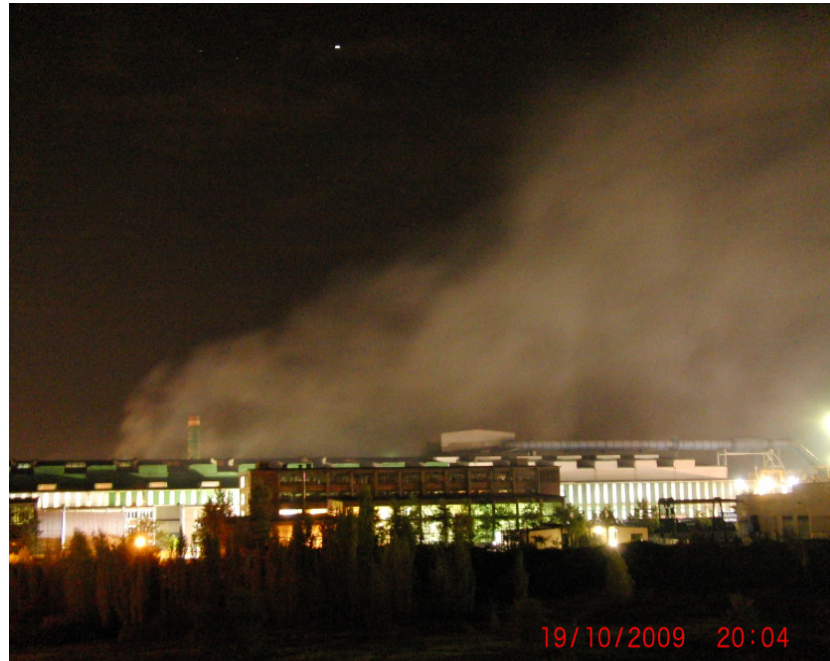
Abb. 2 Staubemissionen, die durch die Dachluken im Stahlwerk Riesa freigesetzt werden
